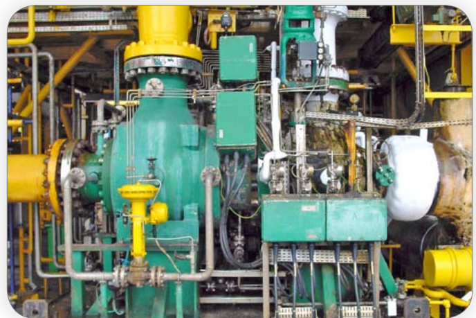
Total N' Kossa (アフリカ)で1996年に運転開始したS2M磁気ベアリングを装備したGE Rotoflowの例
