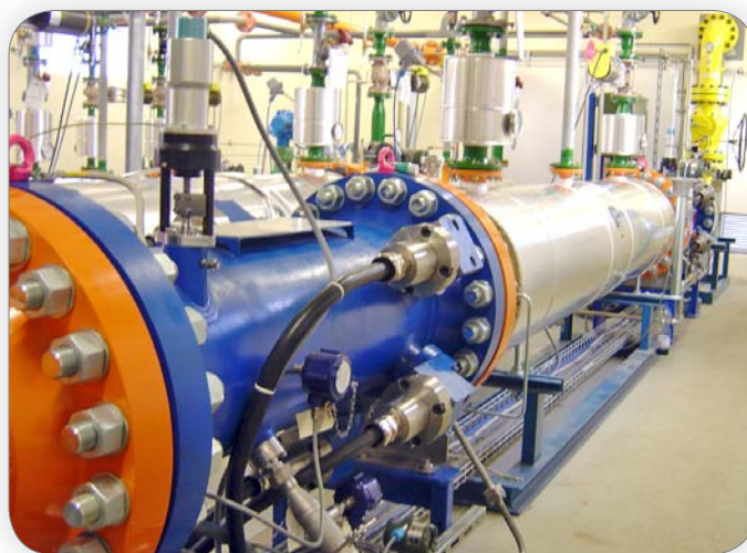
На станции GAS VERBUND MITTELLAND (GVM), оборудованной ДГА S2M, вырабатывается до 600 кВт (2 степени).
