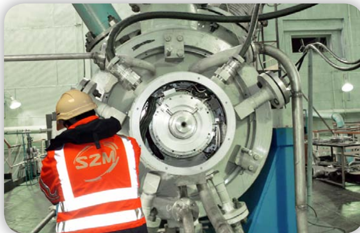
Вид компрессора (со свободной стороны) во время сборки агрегата в цехе.
